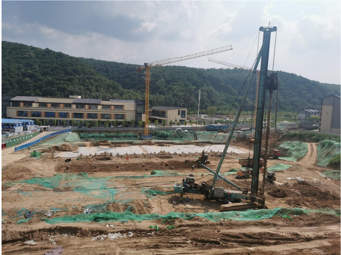
项目地下基坑建设现状
